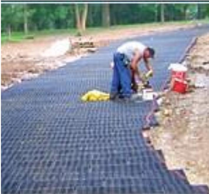
**El Geoblock puede conformar ágilmente un estacionamiento una plataforma o un camino provisional de emergencia para tránsito ligero
