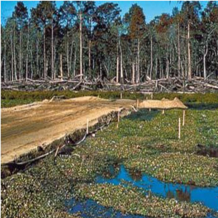
**Combinando las cualidades de un geotextil no tejido con resistencia al punzonamiento superior a 2.7 Kn (ASTM D 6241) y una Geomalla con resistencia a la rigidez flexural superior a 749,000 mg-cm (GRI) se puede establecer un camino de acceso a obra sobre cualquier tipo de suelo blando**
