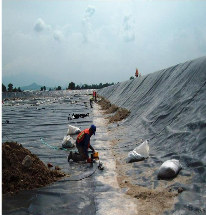
**Las Geomembranas tienen uso ambiental principalmente se fabrican con HDPE\* PP PVC y (Geotex+ bentonita) se usan como barrera impermeabilizante en rellenos sanitarios industria minera, petrolera , química, alimentaria hospitales campos de golf túneles y toda actividad que produce desechos tóxicos o peligrosos para la salud**
