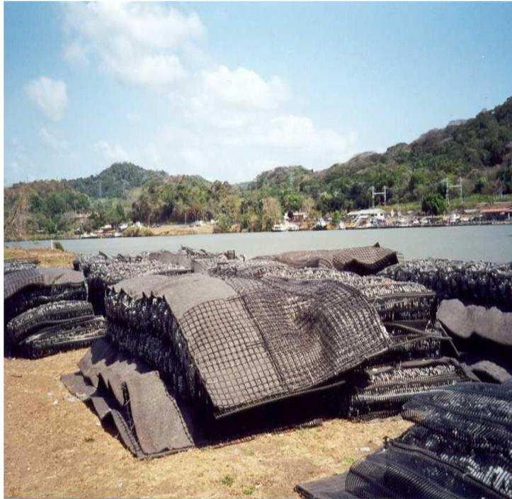
**El Geocolchon puede conformar ágilmente un pedraplen confinado en módulos de Geomalla que tenga resistencia a la tensión superior a 42 Kn/m creep LT y protección UV mayor a 90% las características de confinamiento y flexibilidad le permiten reacomodo y afianzamiento en el tiempo**
