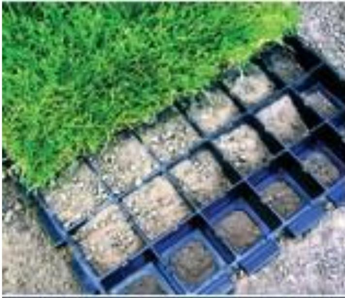
**El geoblock es totalmente rígido fabricado de PP es un material de refuerzo modular con espesores de hasta 10 cms se coloca y rellena con grava o grava arena manualmente es muy rápido y fácil de instalar es muy solicitado para crear estacionamientos “verdes”**
